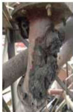
REEMPLAZO DE CODO: LINEA DE TRANSPORTE PULPA MAGNETITA DE VANADIO-TITANIO
