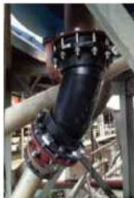
REEMPLAZO DE CODO: LINEA DE TRANSPORTE PULPA MAGNETITA DE VANADIO-TITANIO
